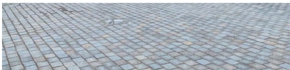
Figur 8: Brostein med sagd overflate. Godt egnet for alt rullende materiell.
