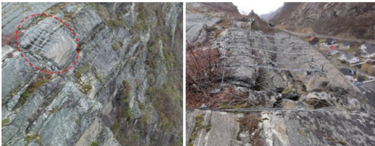
Figur 29: Lokalitet 6 – Karakteristisk blokk, sikret med bolter, fjellbånd og wirenett, (se også Figur 28).
