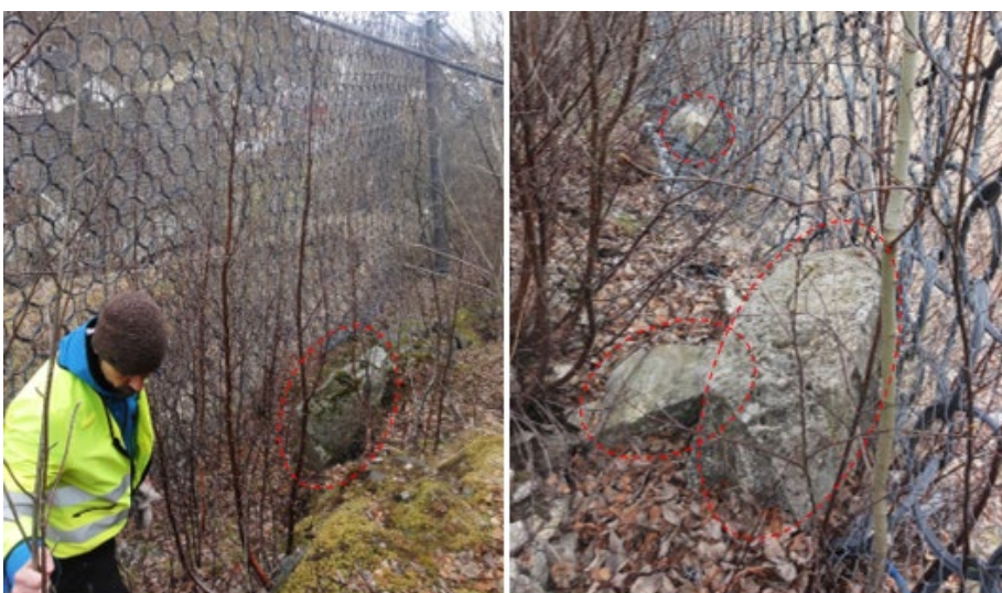
Figur 33: Lokalitet 8: Eksempler på nedfall som er fanget opp av fangnettgjærde
