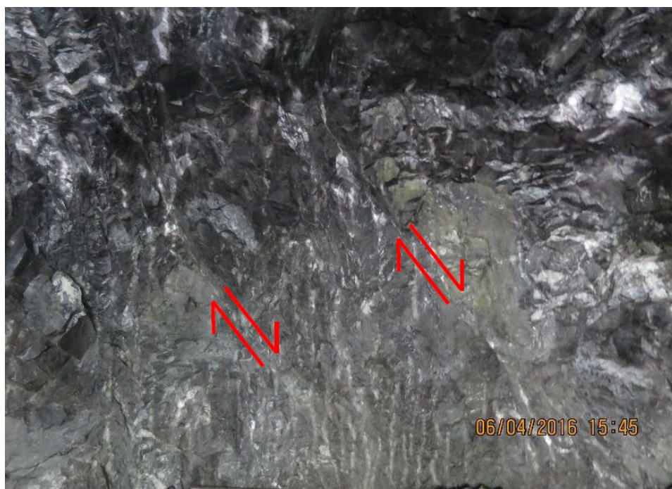
Figur 11: Bilde fra tunneldriving igjennom et tilsvarende (vest – øst) lineament
