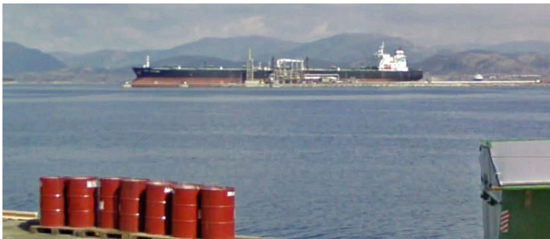
Figur 25: Kaianlegget ved Mongstad sett fra landsida. Gangbru på peler sees i fremre halvdel av skipet Google).
