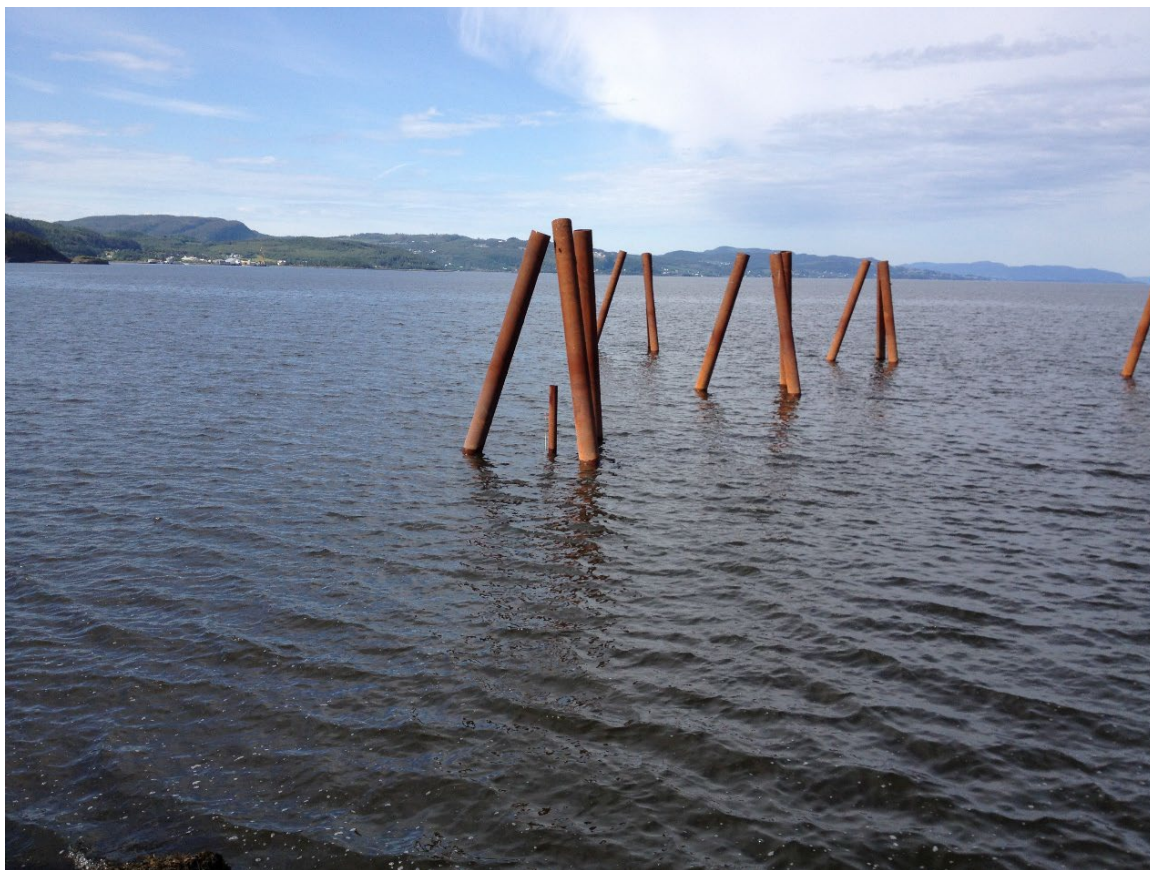
Figur 21: Pelerekke til gangbru og lysmaster, Værnes (Norconsult)
