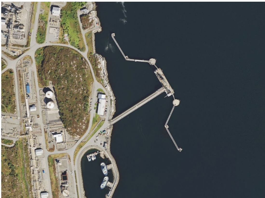
Figur 23: Kaianlegg ved Sture i Øygarden. Bruspennet er på ca. 70 meter (Norge i Bilder).
