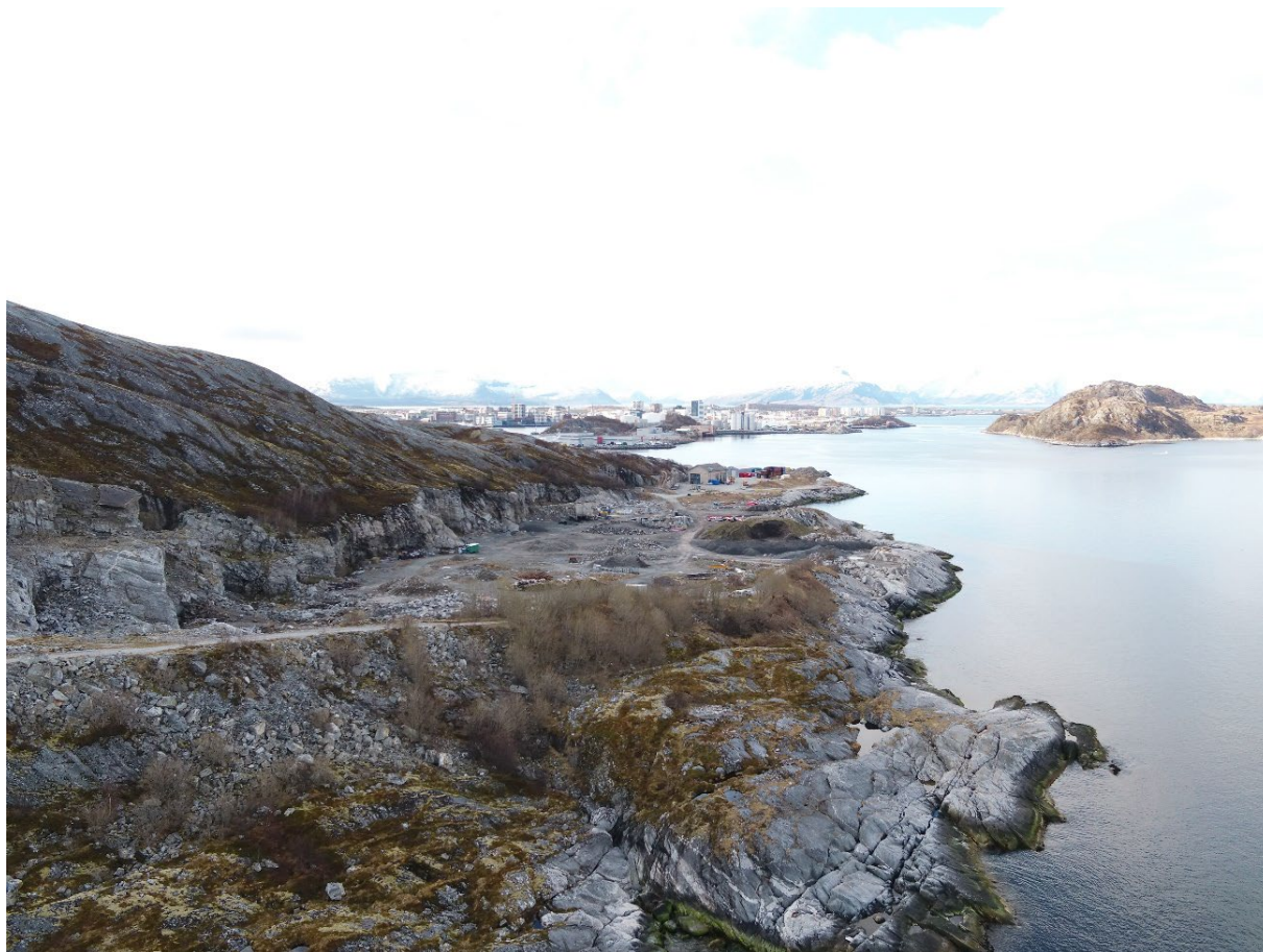
Figur 5: Masseuttaket slik det ser ut i dag. Foto er tatt nord for masseuttaket. Sentrum av Bodø med Bodø havn sees i bakgrunnen midt i bildet.
