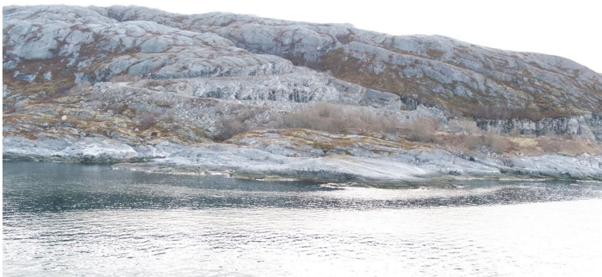
Figur 18: Dronebilde fra sjøsiden. Bildet er tatt fra vest mot øst, og viser hvordan buffersonen med bevart berg og vegetasjon skaper en viss naturlig innramming av bruddet og en skjerm mot innsyn til de lavere partiene i eksisterende brudd. Utvidelsen av bruddet vil stort sett skje i terreng som ligger over innsynsskjermen, og derved bli eksponert mot sjøsiden.
