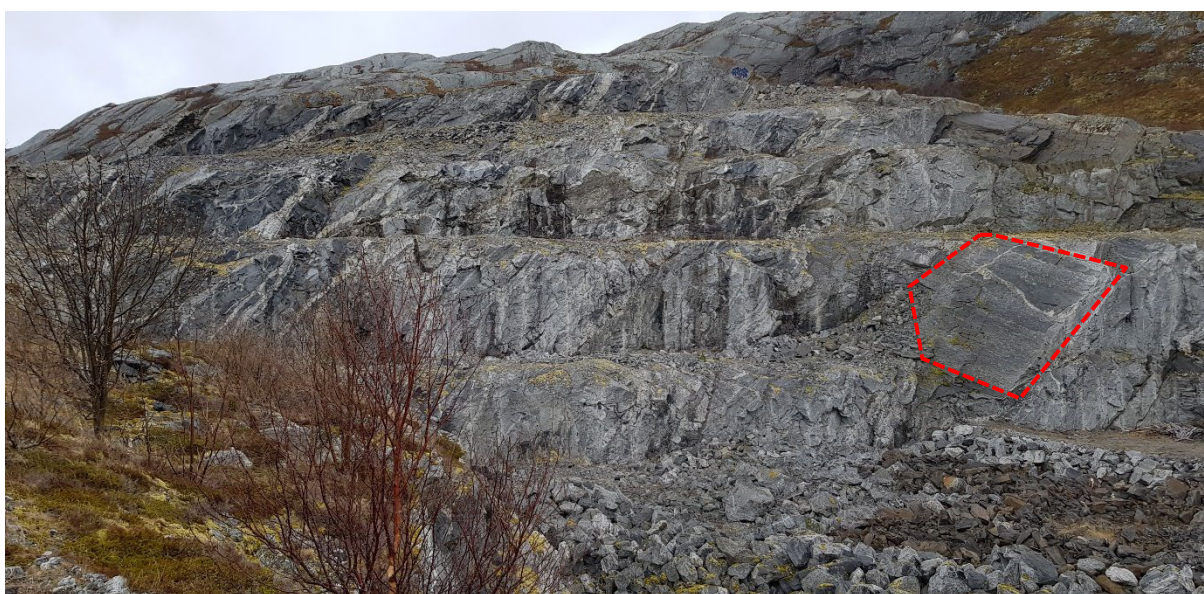
Figur 17: Foto av bergskjæringer i eksisterende uttaksområde. Eksempel på dominerende sprekkesett vist med rød stiplet innramming.
