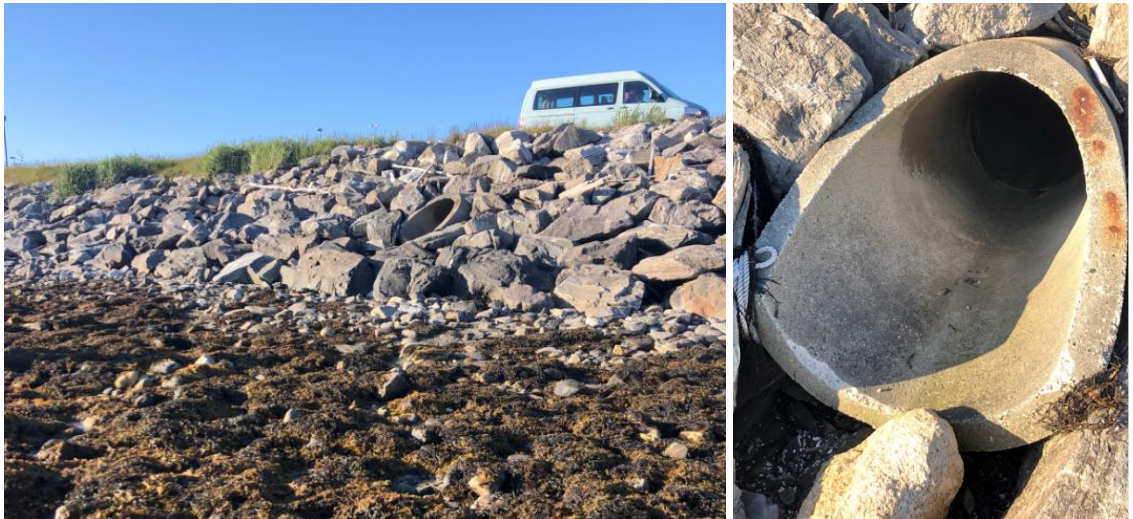
Figur 4 Utslippspunkt 8 ved Giæverneset består av en kulvert under Fv 862.
