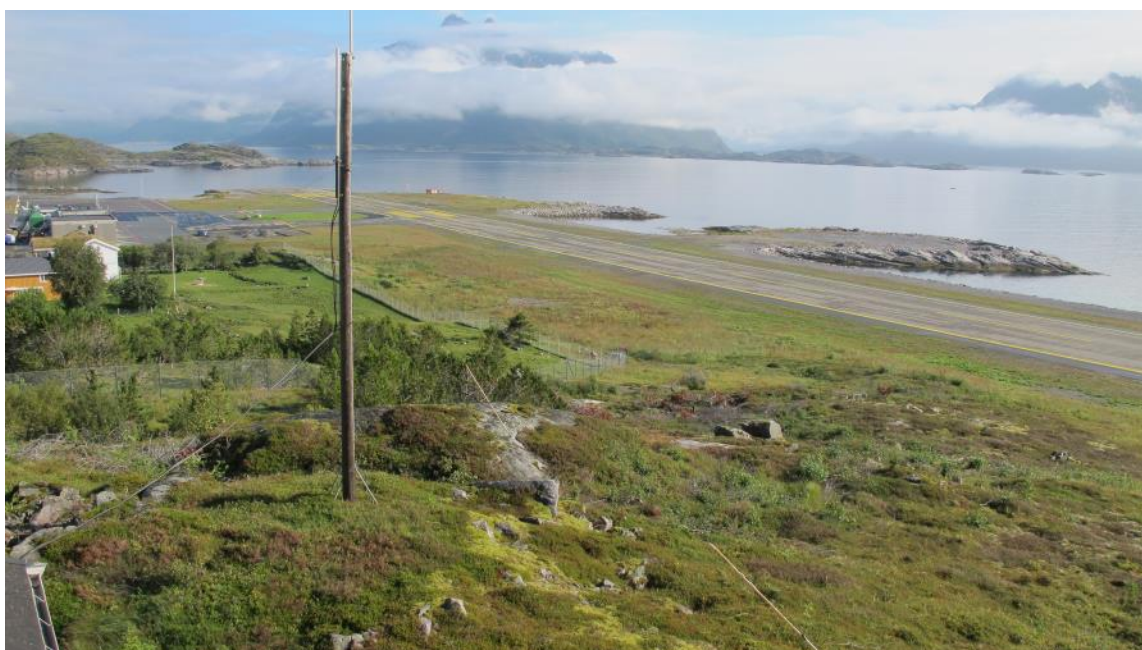
Figur 7. Nordlige del av rullebanen med sidearealer, samt terminalbygg til venstre i bildet. Fra tårnet, mot nord. Foto: Oddmund Wold.
