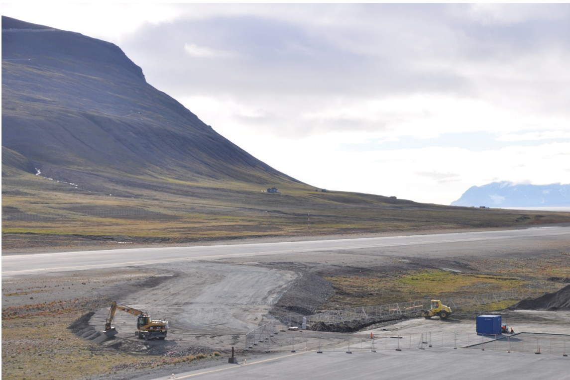
Figur 9. Rullebanen, terminalområdet og sidearealene ligger i hovedsak på fyllmasser. Foto: Oddmund Wold.
