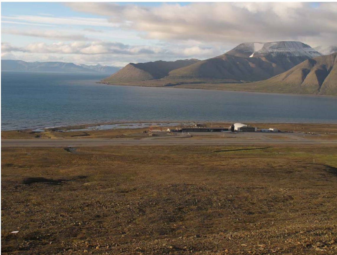
Figur 2. Deler av Svalbard lufthavn sett fra sør. Foto: Rune Solvang.
