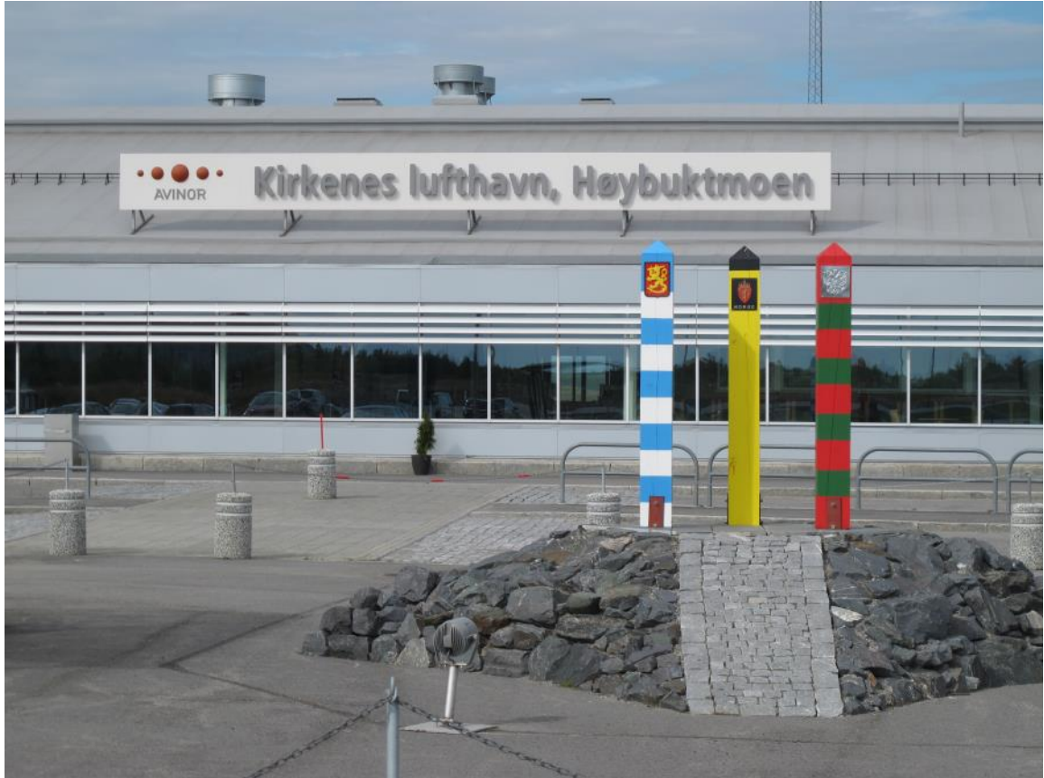
Figur 1. Terminalbygget Kirkenes lufthavn, Høybuktnmoen. Foto: Heiko Liebel.
