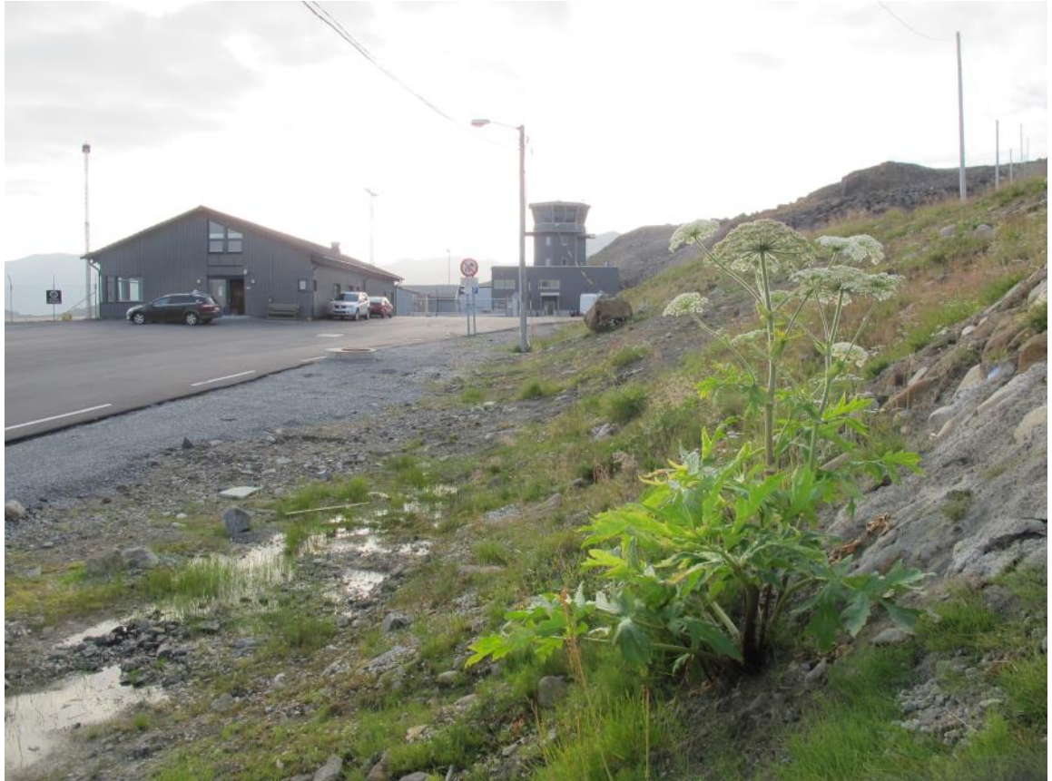
Figur 1. Terminalbygget Honningsvåg lufthavn. Legg merke til tromsøpalme i forgrunnen. Foto: Heiko Liebel.
