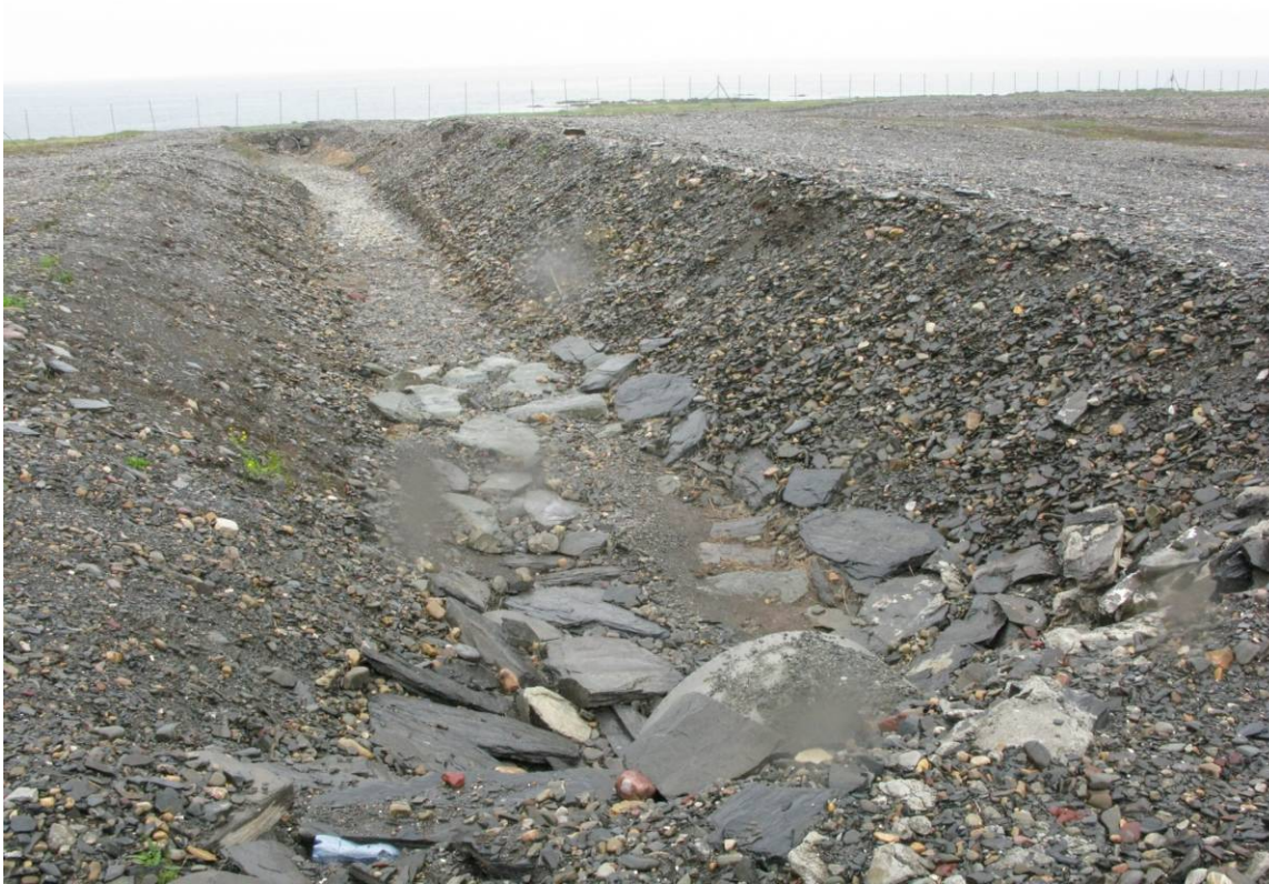
Figur 12. Det er nylig gjennomført grøfting av en bekk/sig som rant gjennom Berlevåg lufthavn. Rapporten som nå foreligger om biologisk mangfold på lufthavnen gjør at man nå kan inkludere kunnskap om biologisk mangfold ved vurderinger av endret arealbruk i området.
