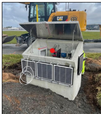
Figur 15 - Solceller på en slags kum over bakkenivå med utstyr for belysnings langs internvei
