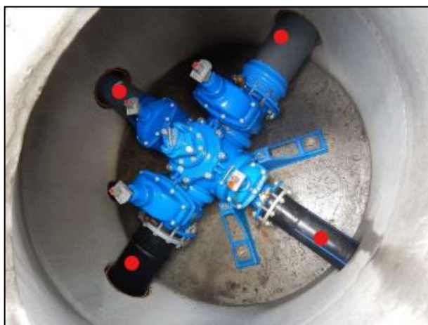
Figur 22 - Innmåling av vannrør i kum gjøres punktvis topp rør. I grøft måles det på røret med maks avstand 10 meter mellom målepunktene. Avvik mellom 2 målepunkter skal aldri være større enn 0,5 meter.
