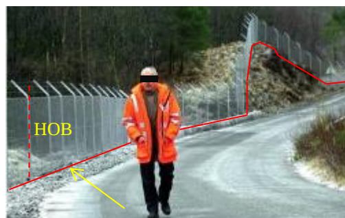
Eksempel på lufthavngjerde rundt Flesland lufthavn.
