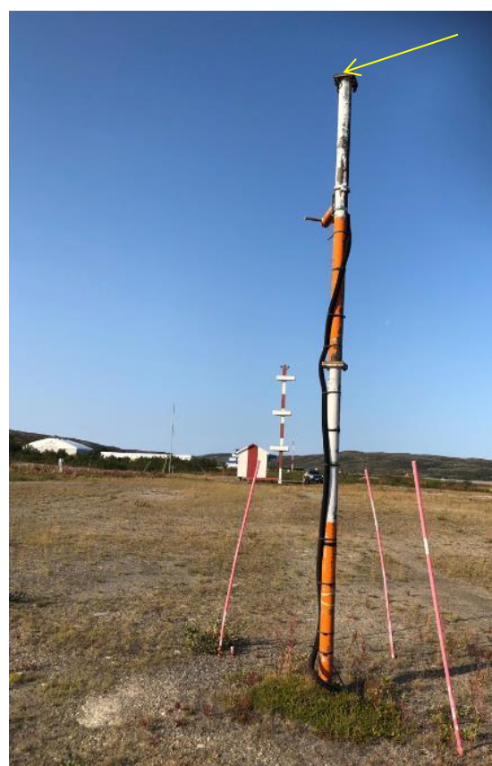
Eksempel på GP-nærfeltmonitormast på Kirkenes lufthavn, Høybuktmoen
