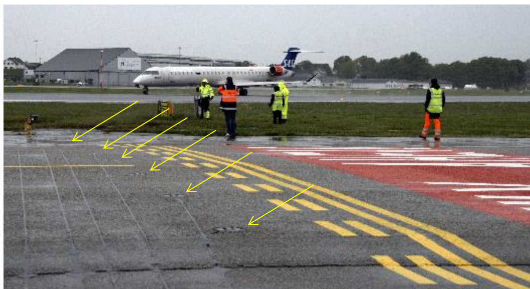
Stopplysrekke, nedfelt lys på Stavanger lufthavn, Sola
