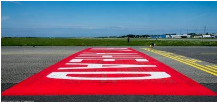
Eksempel på instruksjonsmerking på Stavanger lufthavn, Sola
