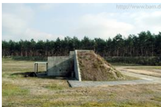
Eksempel på sprengkammer.
