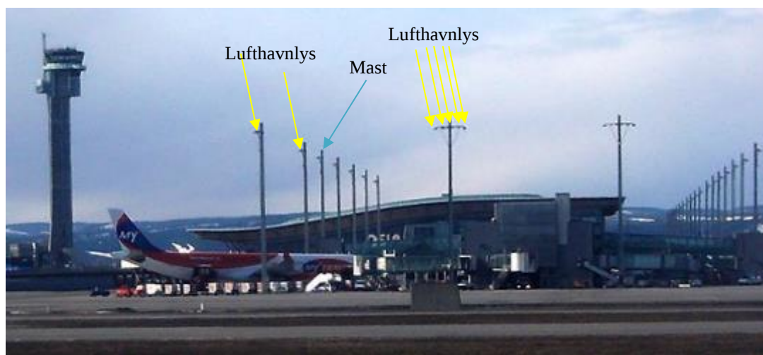
Flombelysning i stolper på Oslo lufthavn, Gardermoen
