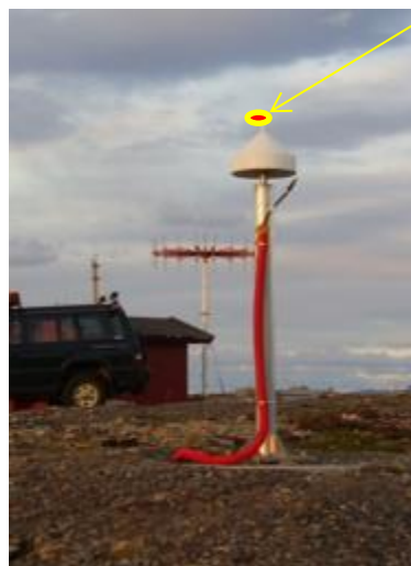
Eksempel på IMS/GRS-mottakere på et SCAT-I anlegg. T.h. LufthavnInstrumenthytte med VHF-antenne i bakgrunnen.
