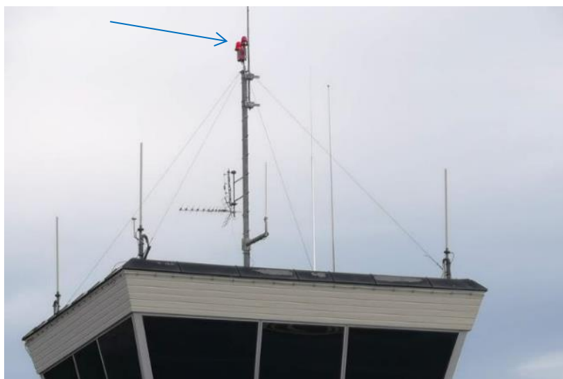
Hinderlys dobbelt t.v., hinderlys på vindpølsestolpe t.h., hinderys på tårn under
