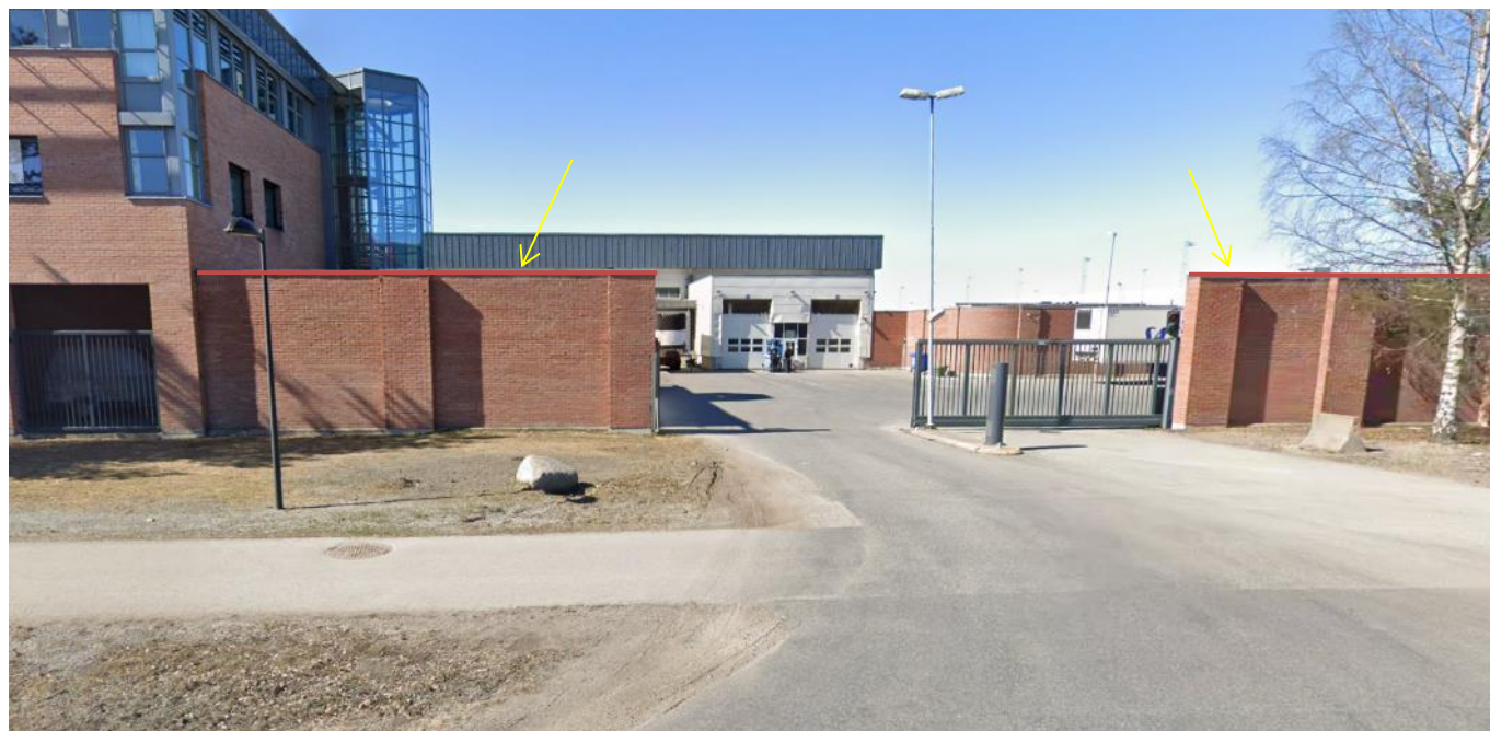
Sikkerhetsmur på Oslo lufthavn, Gardermoen
