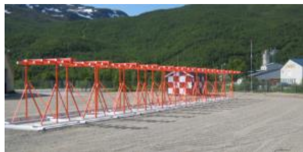
Øverst: Skisseform på hvordan de enkelte element registreres Nederst: Bilde av et LOC-anlegg på Sørkjosen lufthavn
