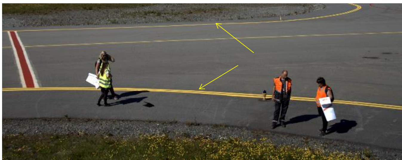
Eksempel på kantmerking (oppstillingsplattform) på Florø lufthavn
