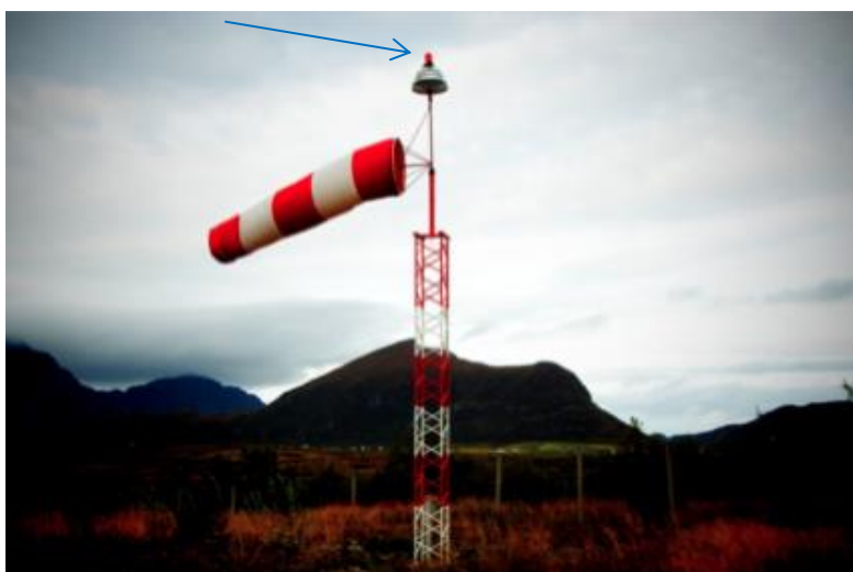
Hinderlys dobbelt t.v., hinderlys på vindpølsestolpe t.h., hinderys på tårn under
