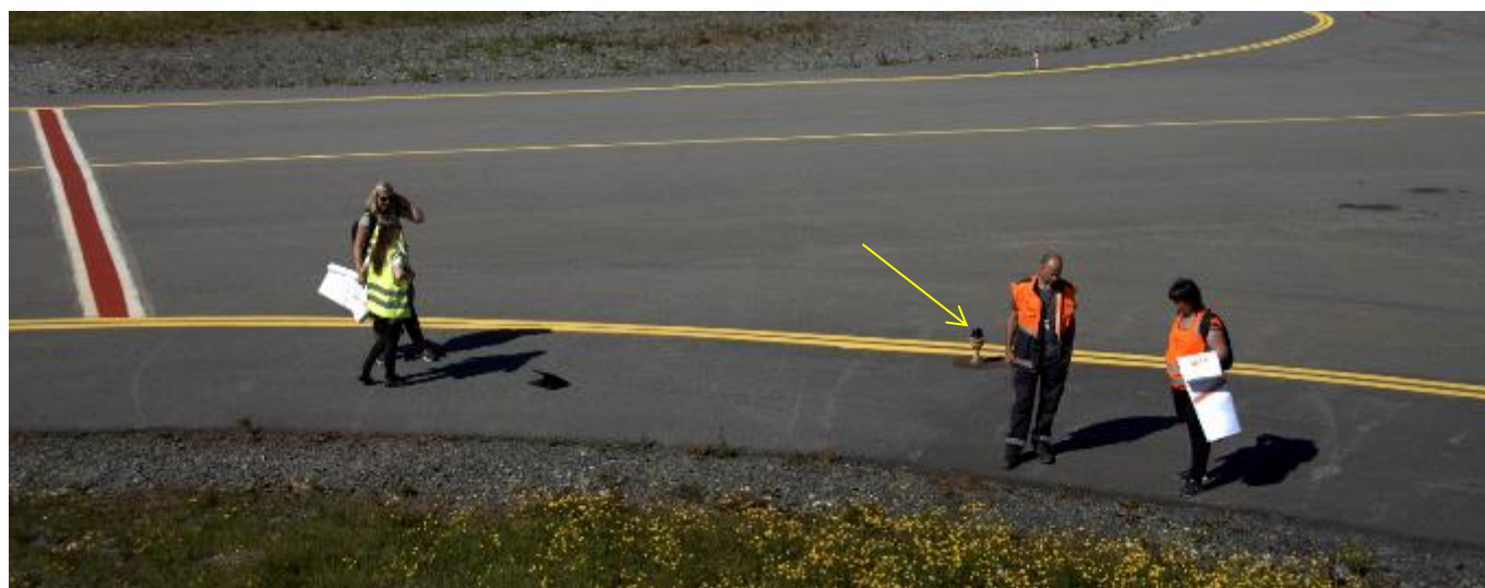
Taksebanekantlys på Oppstillingsplattform på Florø Lufthamn.
