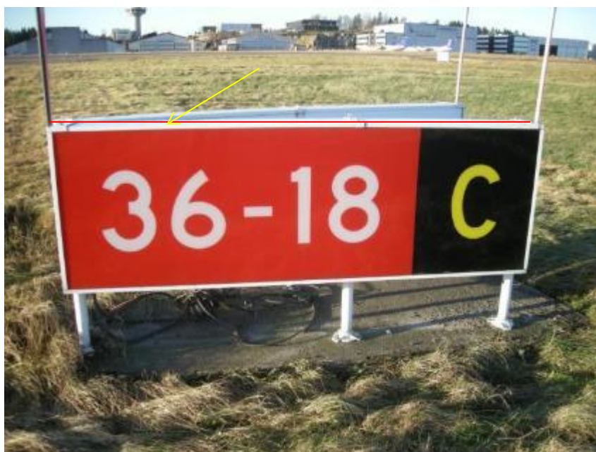
Posisjon / venteposisjon rullebane-skilt på Sandefjord lufthavn, Torp
