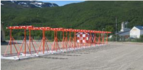
Bilde av et LOC-anlegg på Sørkjosen lufthavn
