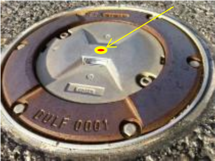
T.v.Markeringslys for senterlinje T.h. Markeringslys for senterlinje med 60 meters avstand på Kristiansand lufthavn, Kjevik (CAT I)
