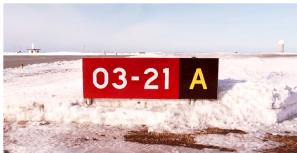
Venteposisjonsskilt for rullebane (reflekterende)
