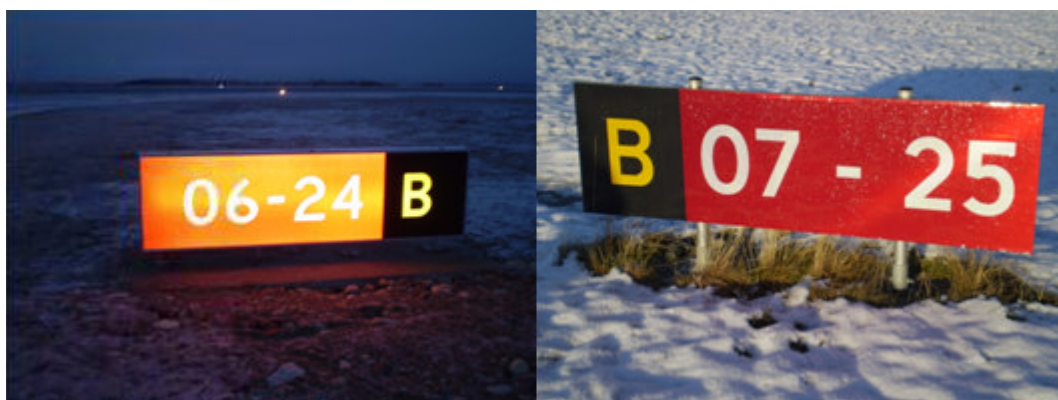
Venteposisjonsskilt for rullebane (opplyst og reflekterende)
