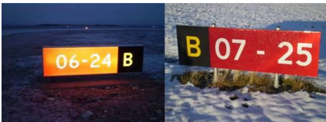
Venteposisjonsskilt for rullebane (oplyst og reflekterende)
