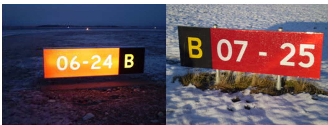
Venteposisjonsskilt for rullebane (opplyst og reflekterende)
